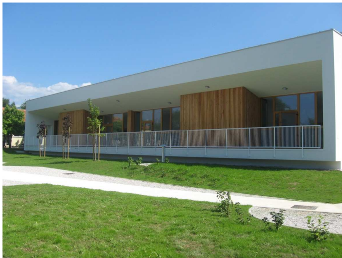
Slika 4: Zunanost objekta vrtec Ribnik 2
