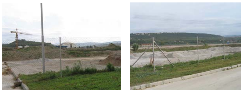
Slika 9: Fotografiji z ogleda čistilne naprave in kanalizacijskega sistema v Kopru, dne 5. 10. 2006
