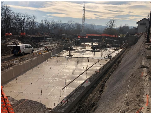
Slika 3 Gradnja Kopališča Vevče
