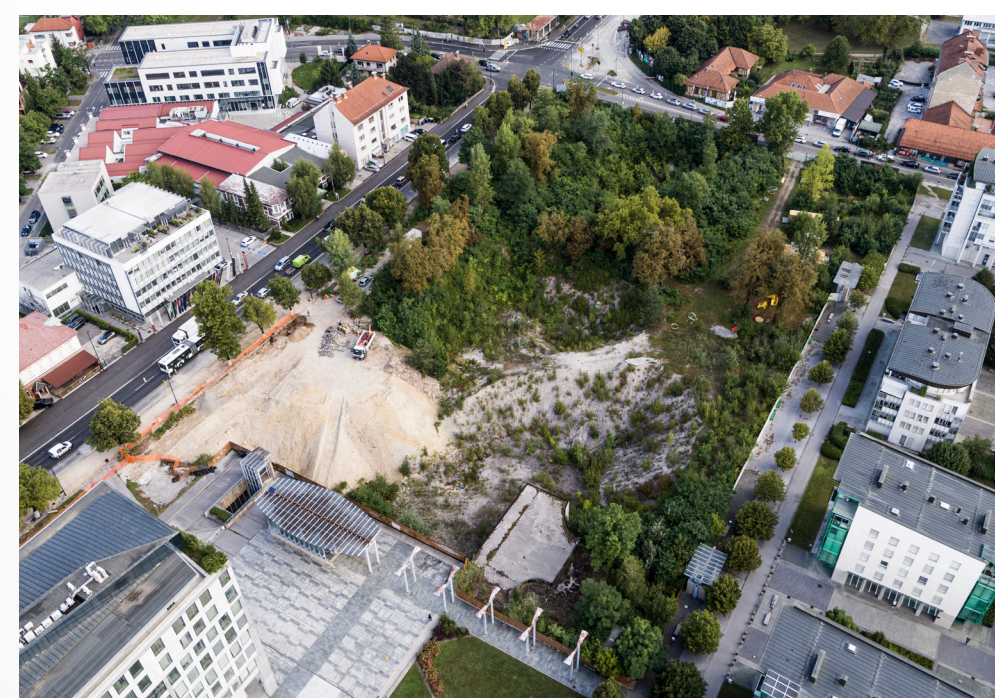
Bežigradski dvor 2021 gradbena jama
