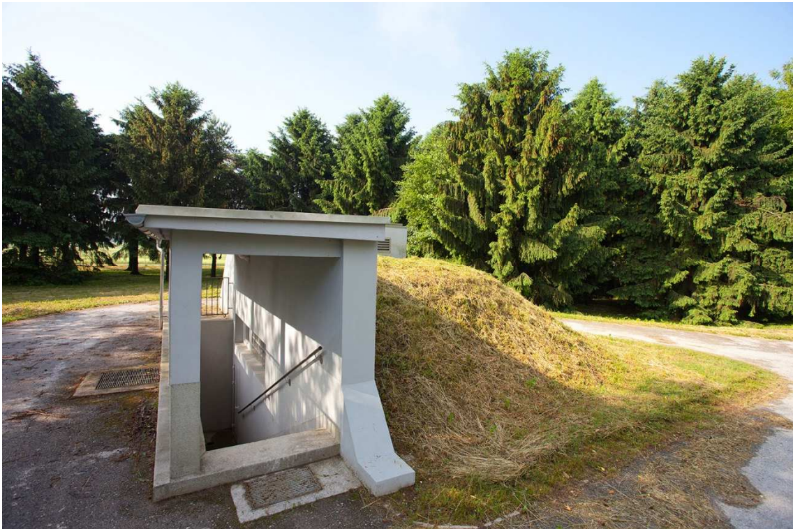
Slika 2 Okolica vodnjaškega 17 objekta in vhod v podzemni del objekta
