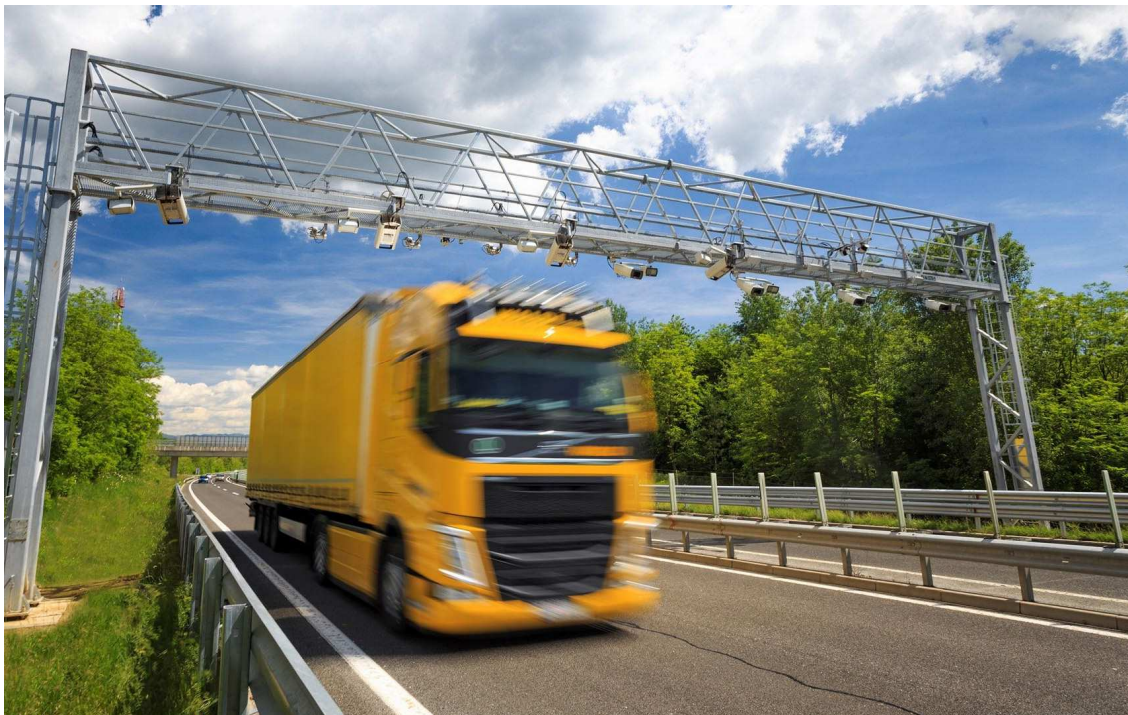
Slika 2 Cestninski portal sistema elektronskega cestninjenja vozil DarsGo
