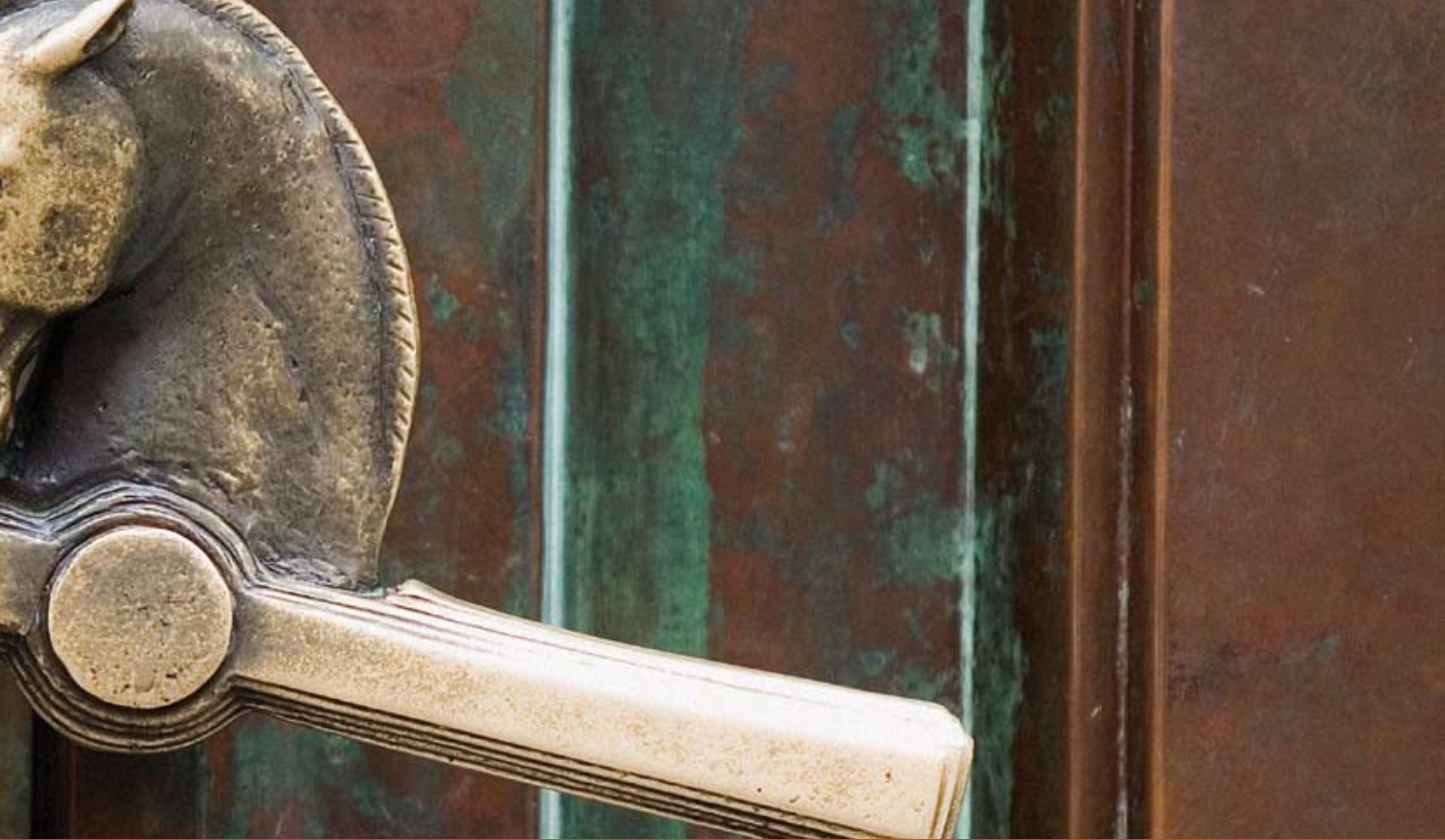
Vhod v stavbo NUK.
