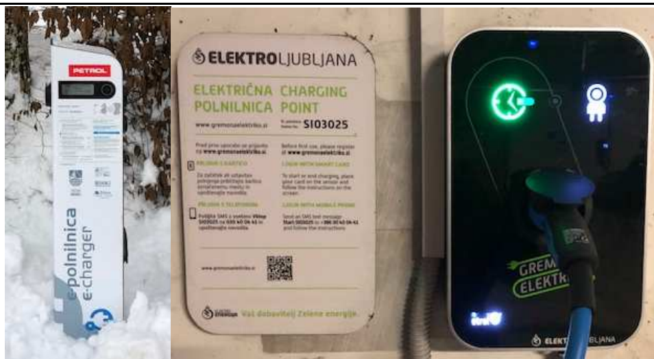
Slika 16: Primer polnilnega mesta na zunanjem parkirišču in v garažni hiši
