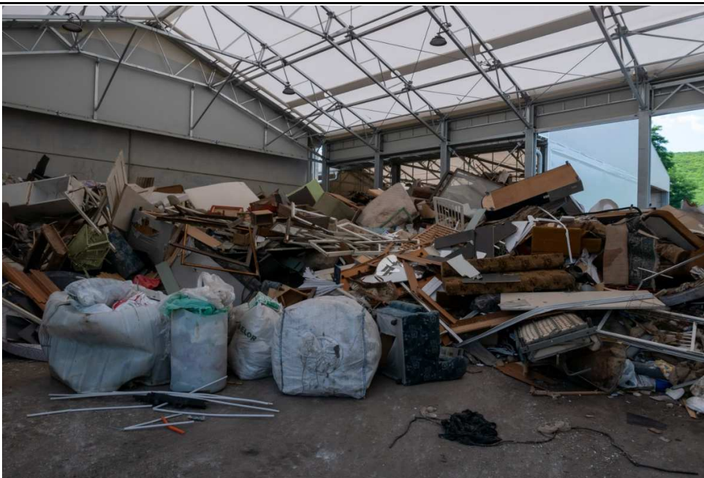
Slika 13: Hala za obdelavo kosovnih odpadkov v okviru infrastrukture CEROP
